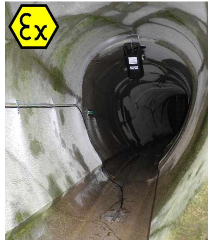
Abb. 1: Berührungslose Sensorik im Eiprofil
