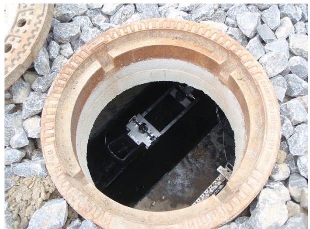
Messstelle auf Deponie
